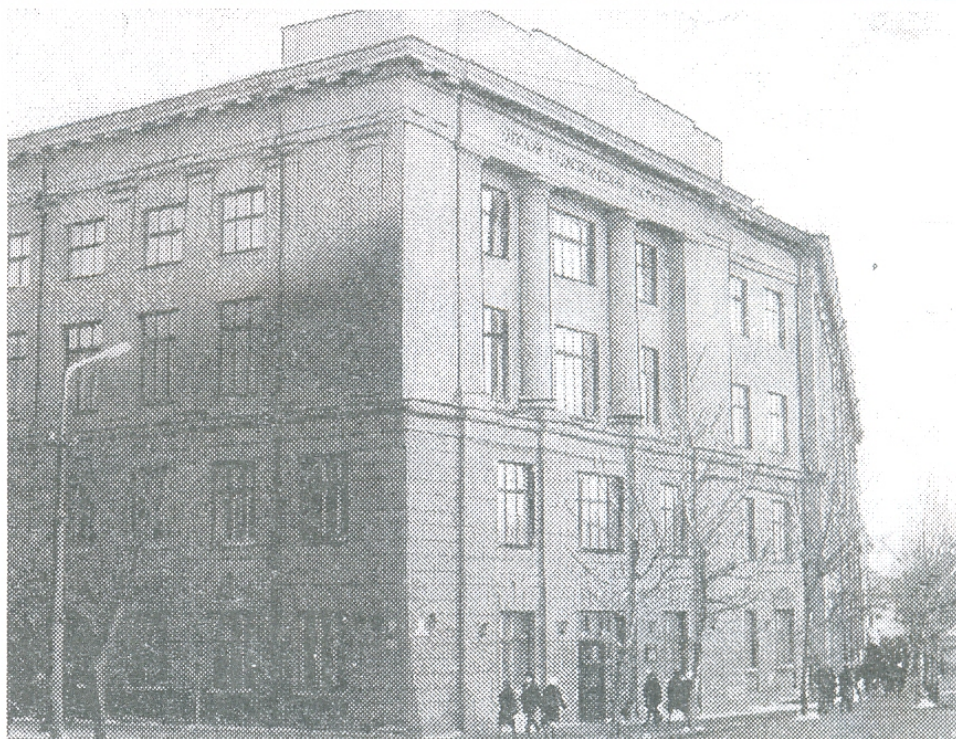
НА СНИМКЕ: корпус №2 ОмГПУ по ул. Партизанской.
