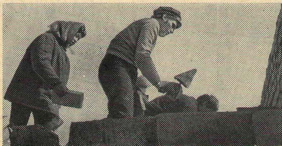
На строительстве общегития.
